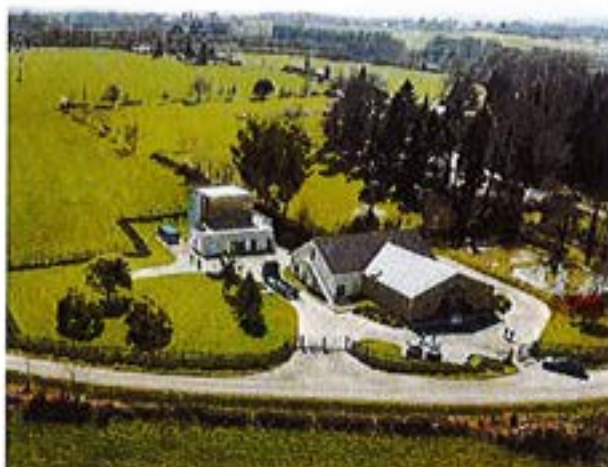
Future usine de Massérac
