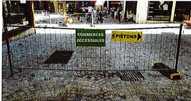
Au droit des traversées piétonnes inévitables (accès charretiers aux logements, traversées de carrefour), **des passerelles piétonnes** seront mises en place afin de permettre aux usagers de franchir les pavés posés en toute sécurité, et de pérenniser le travail en cours de réalisation sur le chantier.
